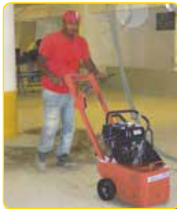
10" 金刚石研磨盘 - 理想地适用于把湿或干的不均匀硬表面研磨至光滑无瑕
